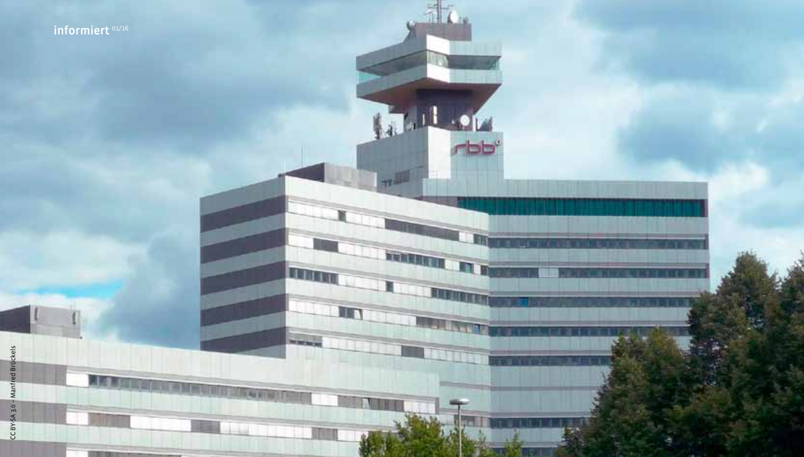
Haus des Rundfunks und Fernsehzentrum am Berliner rbb-Standort.
